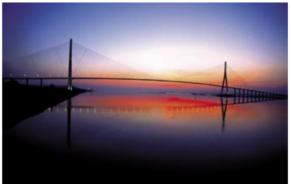
Slika 3 • Most v Normandiji z glavnim razponom 856 m. Projektant Michel Virlogeux. Zgrajen je bil leta 1995, v času izgradnje je imel največji razpon med mostovi s poševnimi zategami na svetu. Foto F. Vigouroux
