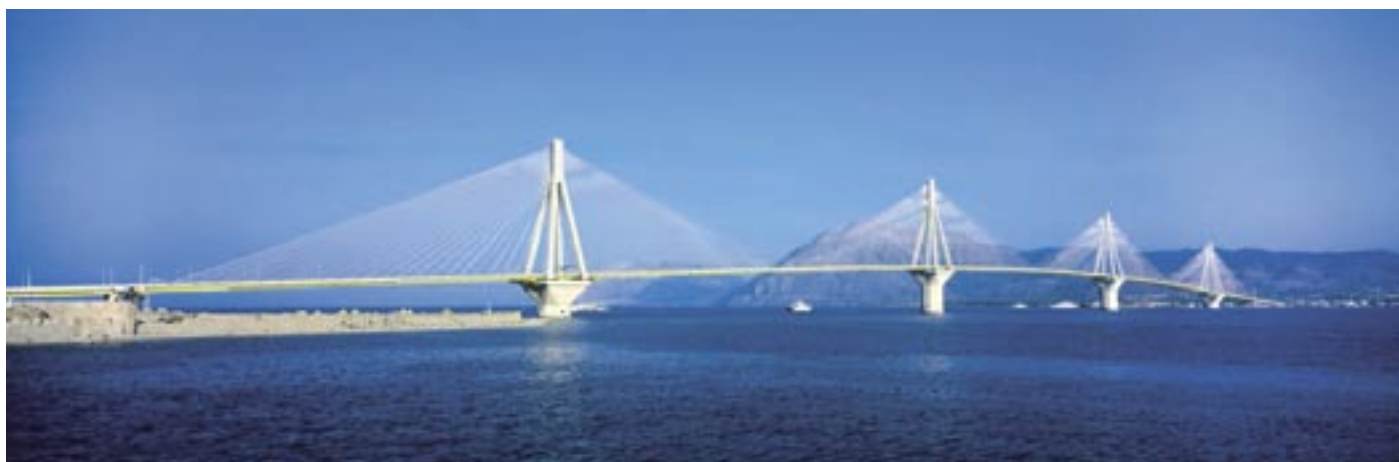
Slika 4 • Most Rion-Antirion pri Patrasu v Grčiji (l. 2004). Dolžina mostu 2250 m, trije glavni razponi po 560 m, štiri nosilni piloti višine 160 m nad morjem. Foto F. Vigouroux
