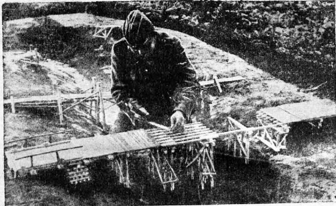
Mladji pionirji se morajo v malem vadiju, da znajo pozneje svoje odgovorno delo izvršiti v velikem. Pionir na gornji sliki gradi most v razmerju 1:20. Most ima v resnici nosilnost 24 ton in je dolg približno 40 metrov.
