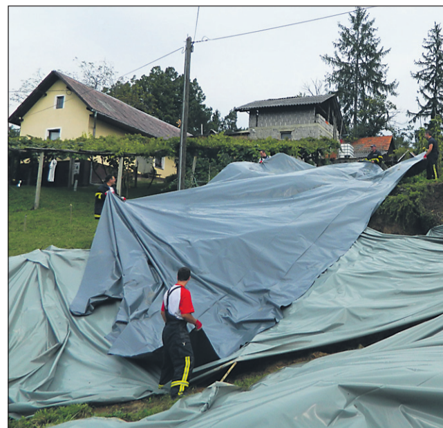
Člani PGD Makole so prekrili plaz v Mostečnem, da bi preprečili nadaljnje širjenje.
