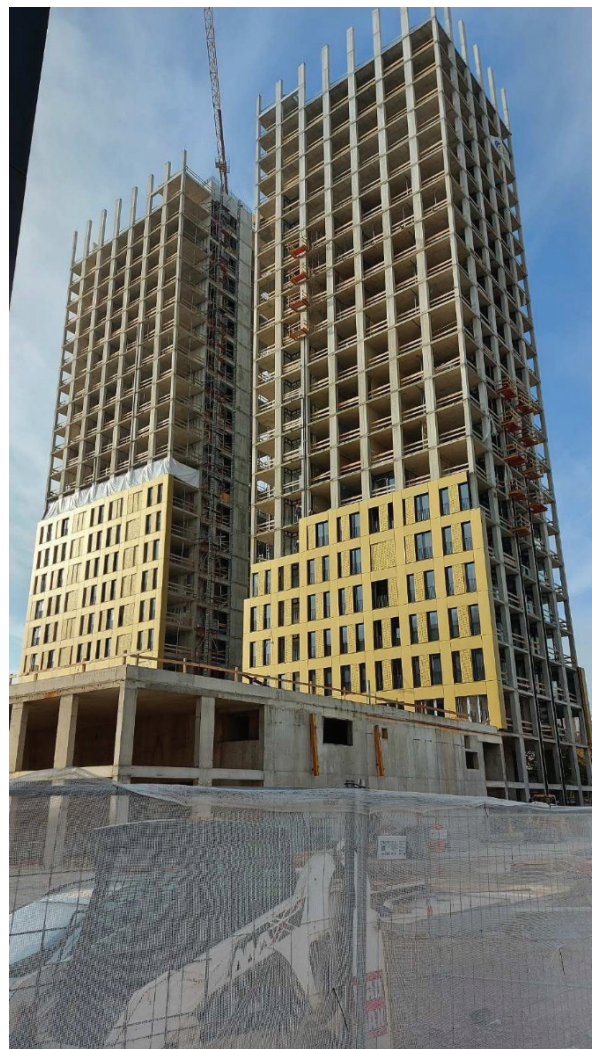
Slika 15. Zaključek gradbenih del, oktober 2022.
