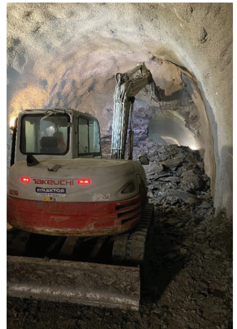
Slika 7. Preboj reševalnega rova, marec 2022.
