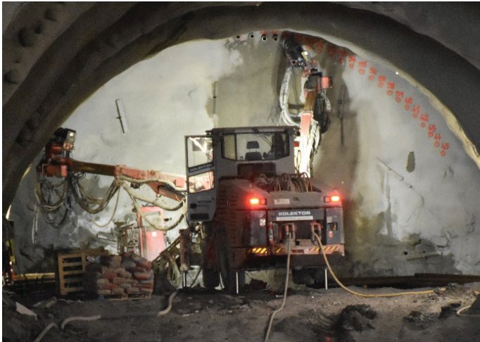
Slika 4. Vrtanje cevnega ščita na južni strani predora, marec, 2022.
