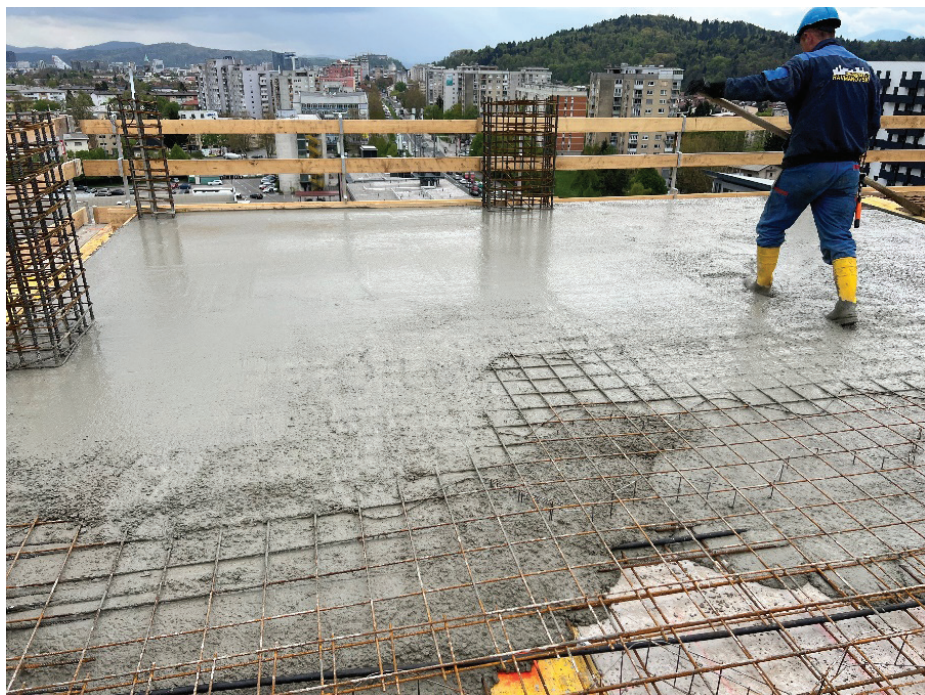
Slika 11. Betoniranje plošče, april 2022.
