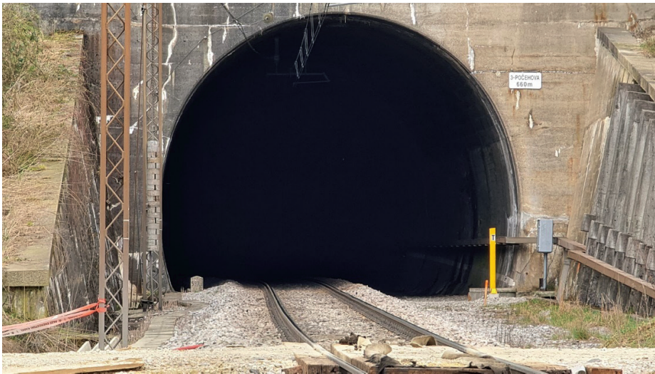
Slika 2. Predor Počehova na obstoječi železniški progi.
