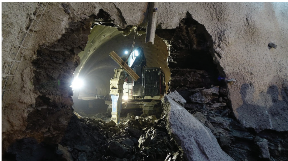
Slika 8. Preboj železniškega predora Pekel, avgust, 2022.
