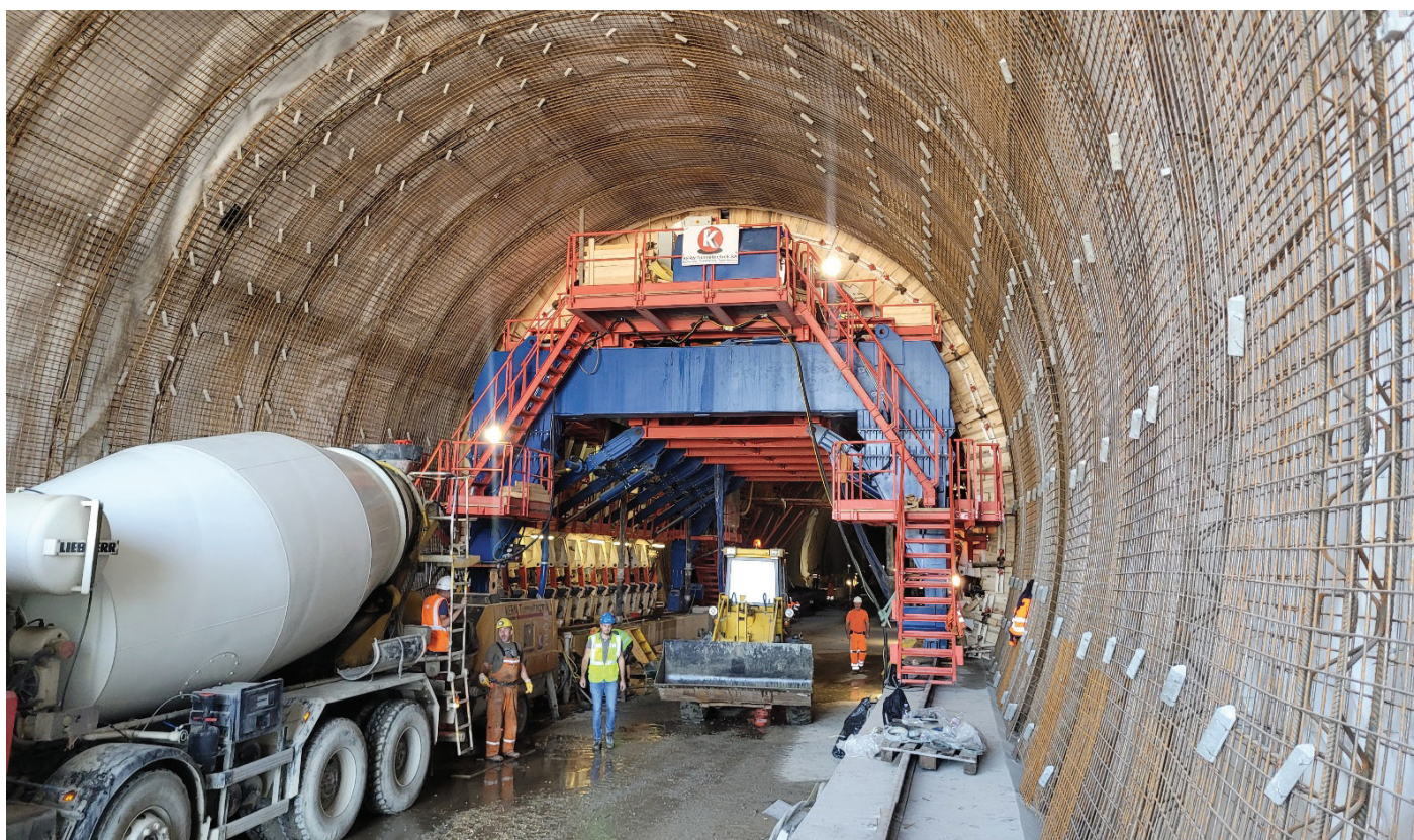
Slika 1. Gradnja predora Pekel na severni strani, september 2022.
