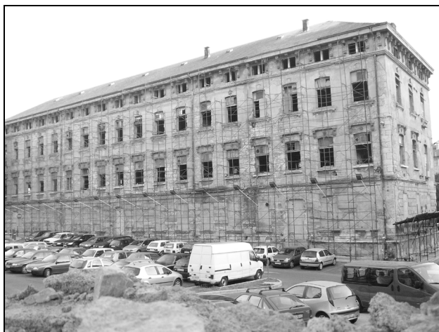
Kompleks nekdanje sladkorne rafinerije (kompleks Rikard Benčič) na Reki.
