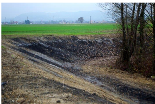
Slika 9: Visok navoz elektrofiltrskega pepela. Avtor: Jože Bregar.
