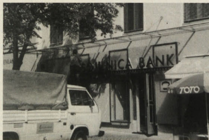
»Finiš« obnove del na Posojilnici-Bank v Beljaku
