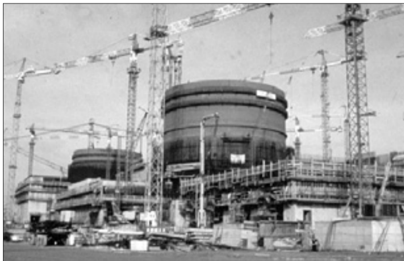
Gradbišče jedrske centrale v Montalto Di Castro
