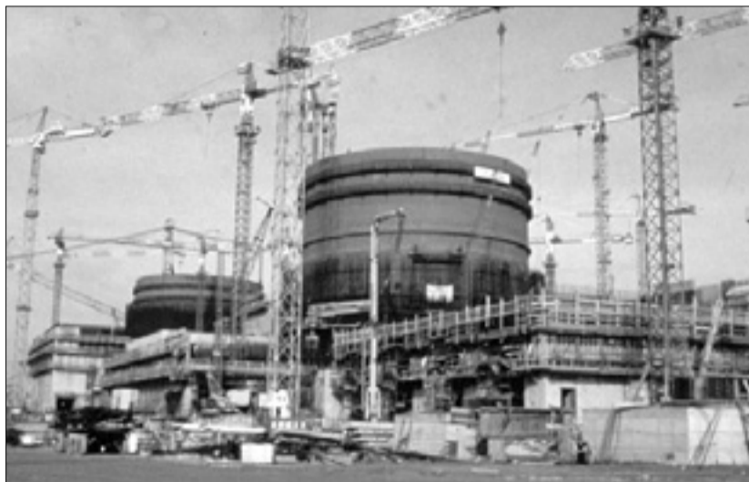
Gradbišče jedrske centrale v Montalto Di Castro
