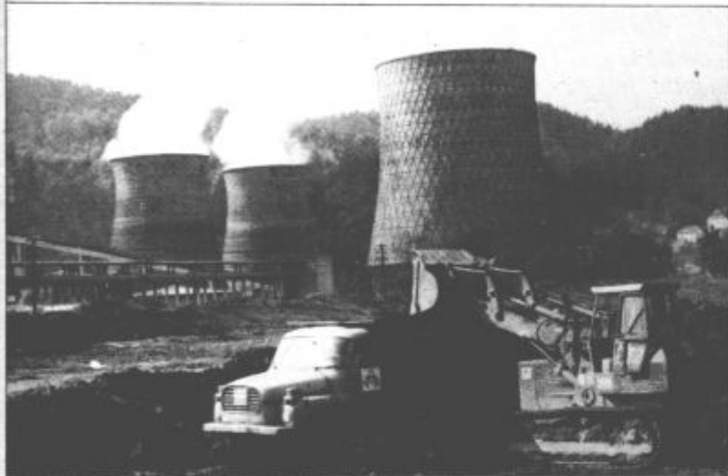
Ob izgradnji nove šoštanjske termoelektrarne so ponosni tudi delavci Gradisa-tozd gradbena enota Celja, saj so bili nosilec večine gradbenih del. Gradbena dela so bila gotova v roku 20. mesecev. Ta uspeh je bil dosežen predvsem zato, ker so že na prejšnjih objektih izvajali gradbena dela in so tako že ustrezno opremljeni za tovrstno gradnjo.
