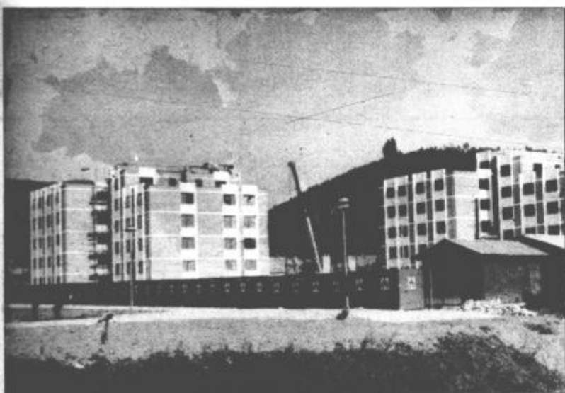
Znaten delež Gradisa v velenjski občini je tudi v stanovanjski in ostali visokogradnji. Med objekti, ki jih prav zdaj gradijo, je tudi novi dijaški dom Rudarskega šolskega centra Velenje.
