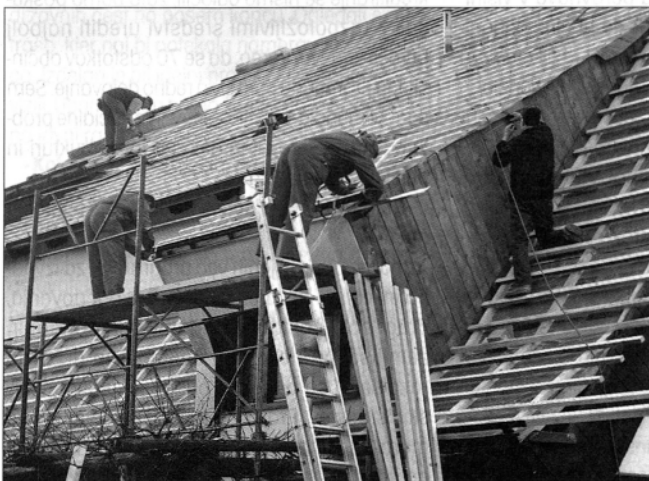
Teden dni je več kot dvajset prostovoljcev in samostojni podjetnik opravljalo različna dela, da je streha dobila novo kritino
