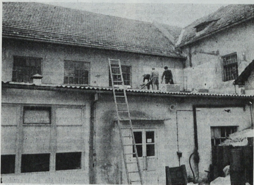
Neznosne vročine poleti v oddelku filtrov bo kmalu konec. Na sliki polaganje TERVOL plošč za toplotno izolacijo strehe. Namestiti bo treba še strešne ventilatorje.
