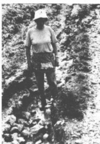
Po tako poškodovani cesti se do hiše pride le še peš
