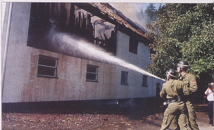
Pri Wunčku v Vogrčah je med delom začel goreti hlev
