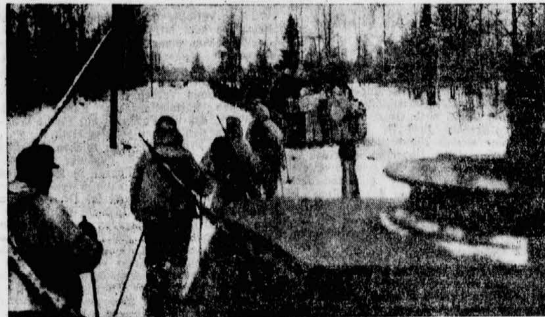
Ein Einschließungsring wird durchbrochen Scherl-Bilderdienst-M.
