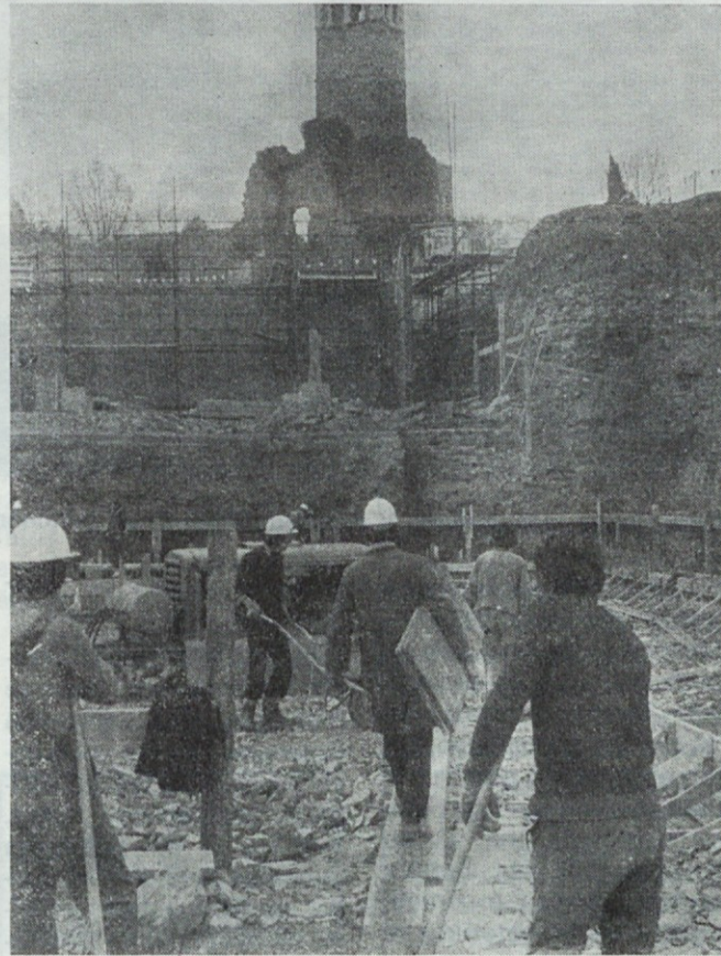
Delo na trenutno največjem gradbišču v SRS teče od zore do mraka
