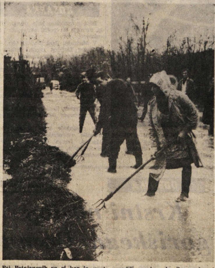
Pri Petejanovih so si kar iz gnoja zgradili nasip, da jim voda ni zalila dvorišča in hiše
