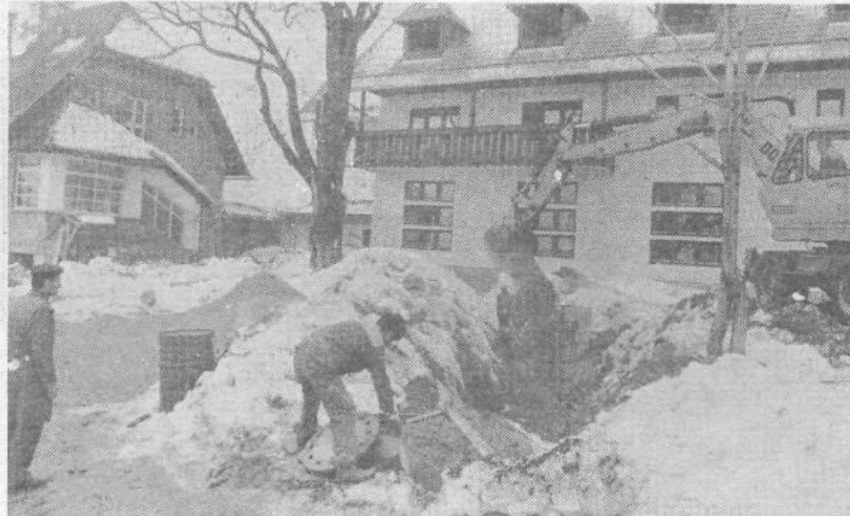
Gradnja na Rakitni se bliža koncu
