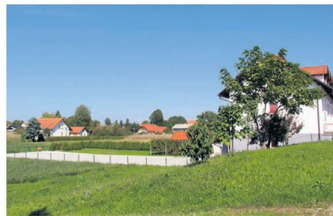
Za izgradnjo dovozne poti (na sliki) v delu naselja Markovci so se potegovali štirje ponudniki.
