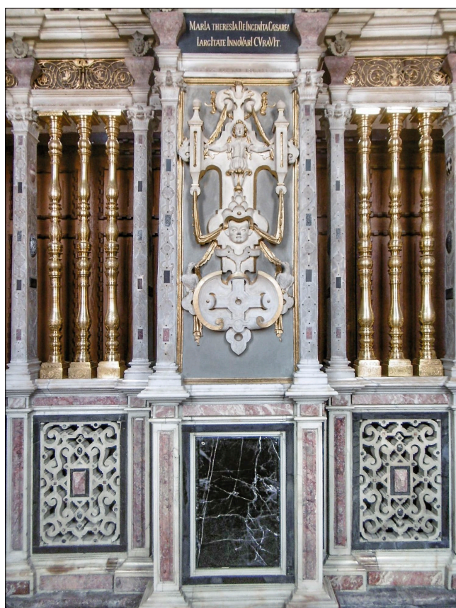
7. Alexander de Verda und Werkstatt: Schrankenarchitektur der Südwand, 1587–1592, Mausoleum, Stiftskirche Seckau
