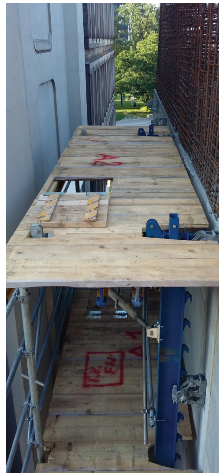
Slika 21: Plezajoči opaž Xclimb 60.
