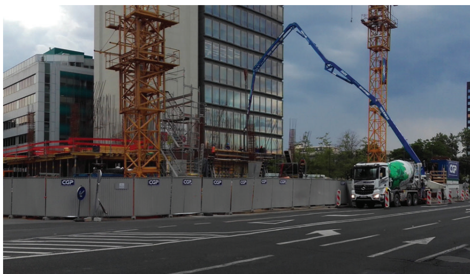
Slika 12: Betoniranje plošče nad pritličjem.
