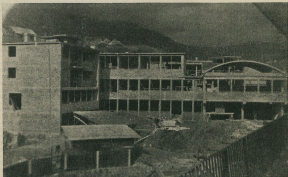
Posnetek iz gradbišča Trbovlje — gradnja poštnega poslopja
