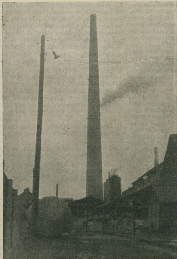
Gradnja novega tovarniškega dimnika v Cinkarni je gotova
