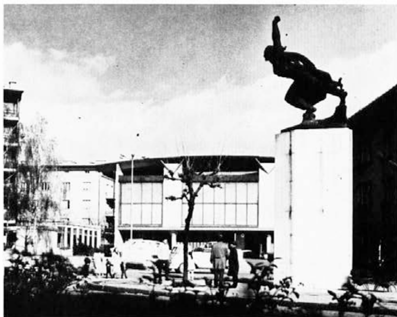
Sl. 104. E. Ravnikar, Okrajni ljudski odbor v Kranju, pogled na celoto, 1958—60
