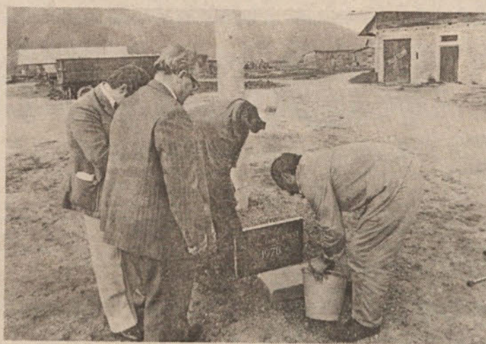
V Brestu bo torej kmalu stala nova, moderna mlečna farma!
