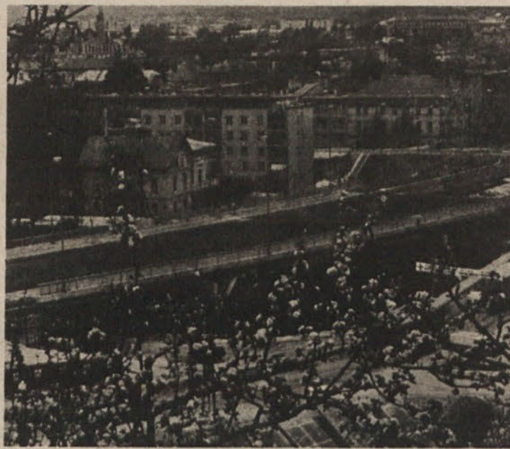
Pogled na delno zgrajen Karlovski most. 10. maja je bil most že odprt za vožnjo v eno smer.
