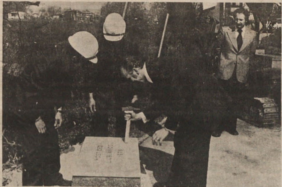
»Da bo bolj trden most!« Predsednik IS France Martinec ob položitvi temeljnega kamna za most čez Ljubljanico.
