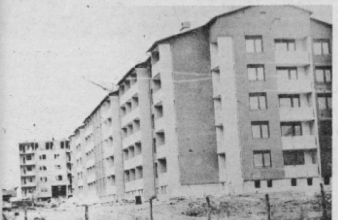
Stanovanjski blok B-4, kjer končujejo z gradbenimi deli. V ozadju že gradijo blok B-3, ki bo končan sredi prihodnjega leta. Foto: J. Bračić
