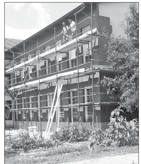
Toplotna izolacija zunanje ovoja na starem delu nazarske osnovne šole.
