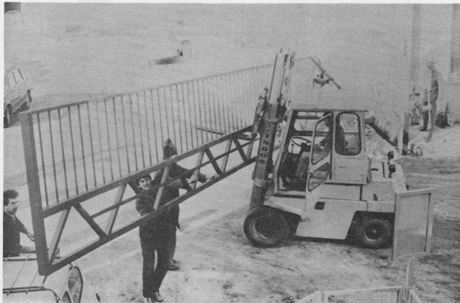
Delavci Komunalnega podjetja Tržič so pred dnevi končali z montažo novih vrat pri glavni vratarnici.
