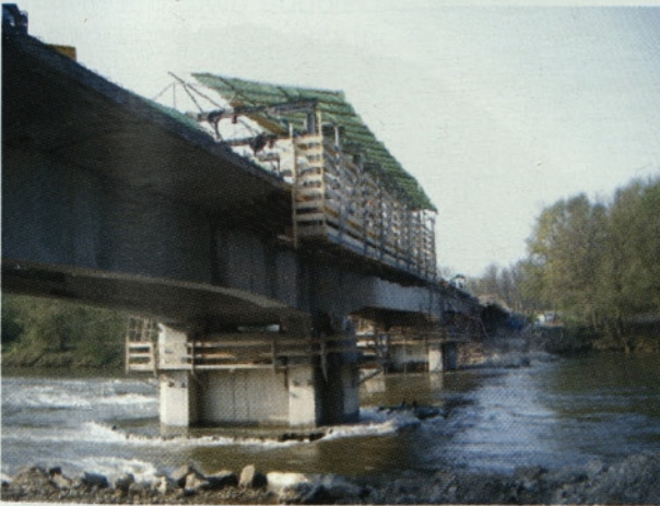
Slika 8: Most čez Muro po zabetoniranju prvega dela nove voziščne plošče
