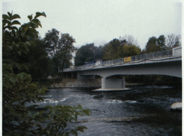
Slika 9: Betonska plošča med rečnimi stebri in zagatnicami ter kamnita obloga rečnih brežin
