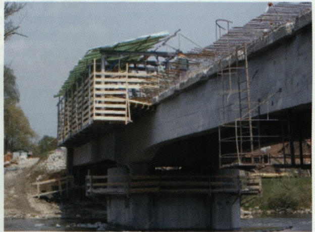
Slika 7: Konstrukcija opaža za novo voziščno ploščo
