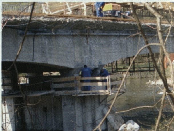
Slika 5: Naslonitev prekladne konstrukcije v času rekonstrukcije ležišč načasne armiranobetonske stebre
