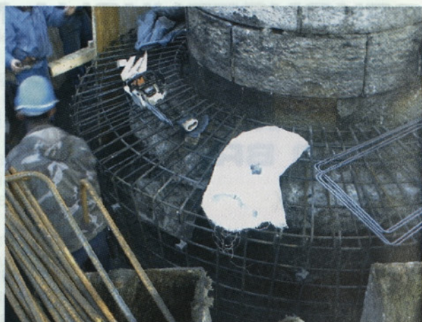
Slika 3: Ojačitev zgornjega dela temeljev rečnih stebrov
