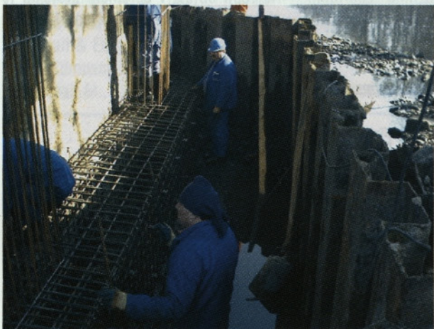
Slika 4: Zaščita temeljne jame za zagatno steno iz leta 1939
