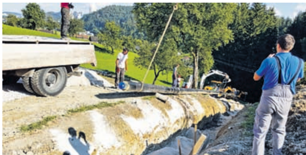
Z največjega delovišča v Šoštanju, kjer so zamenjali več kot 100 metrov dolgo cev.
