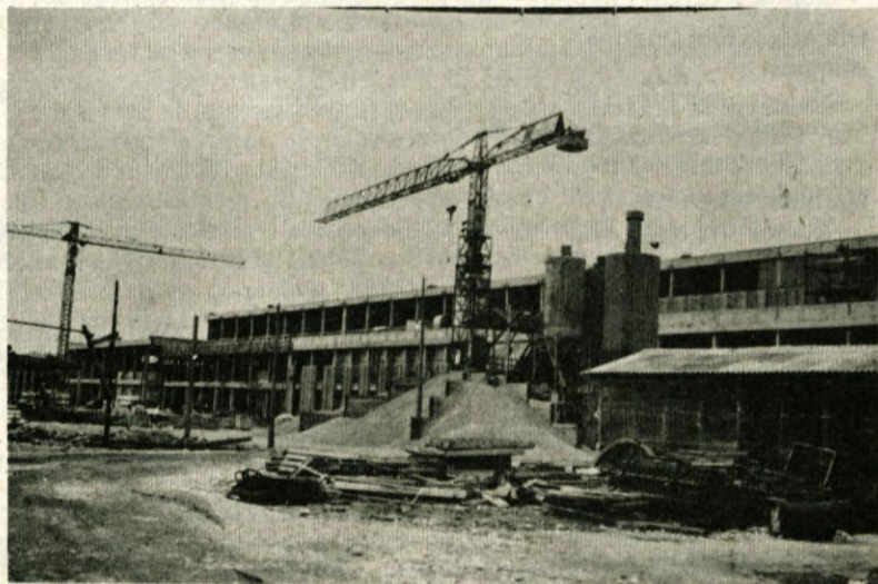
Gradbena dela na največjem objektu v naši občini Papirnici Količevo vidno napredujejo tako, da lahko spremljamo rast te največje proizvodne hale, v kateri bo obratoval novi kartonski stroj. Tudi oprema bo kmalu prišla in začela se bodo monterka dela. Dograditev tega obrata bo velika delovna zmaga kolektiva Papirnice in tudi domžalskega gospodarstva ter vseh, ki so soudeleženi pri tej gradnji
