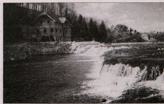
BETON IN LEHNJAK - Takole zdaj izgledajo lehnjakovi pragovi pri Podgozdu. Idilično podobo za Krko značilnih slapov, ob katerih so se v preteklosti vrtila mlinska kolesa, je močno spremenilo gradbišče male elektrarne. Res so v preteklosti nepremišljeni graditelji in ob Krko postavili še veliko grše spake, kar pa ne pomeni, da lahko s takim početjem nadaljujejo. (Foto: I. V.)
