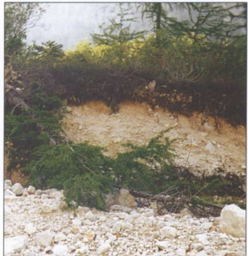
Slika 3. Rob hudourniške struge v krnici Pod Srcem je zelo občutljiv za erozijo. Macesen je izgubil svojo koreninsko oporo in se zrušil v hudourniško strugo, kjer bo propadel (foto: Vilma Vrtačnik Merčun).
