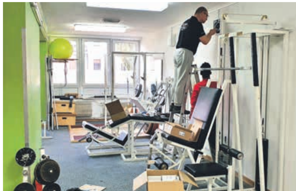
Montaža prezračevalnih naprav v fitnesu
