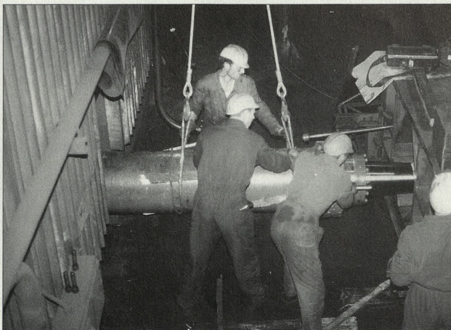
Montaža hidravličnega cilindra
