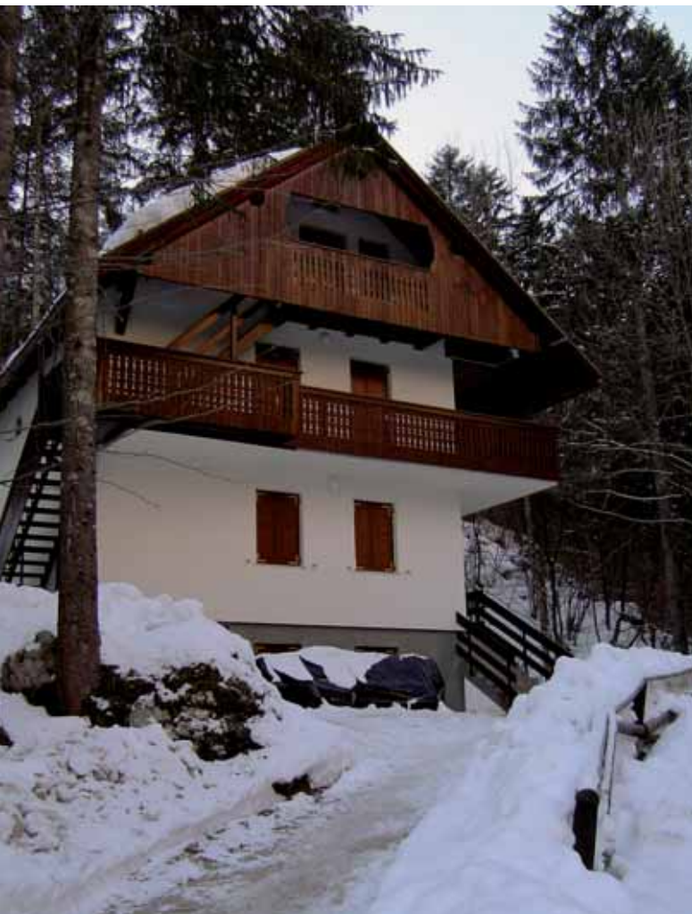
Počitniška enota Ukanc 87 z novo izolirano fasado in novim stavbnim pohoštvom.
