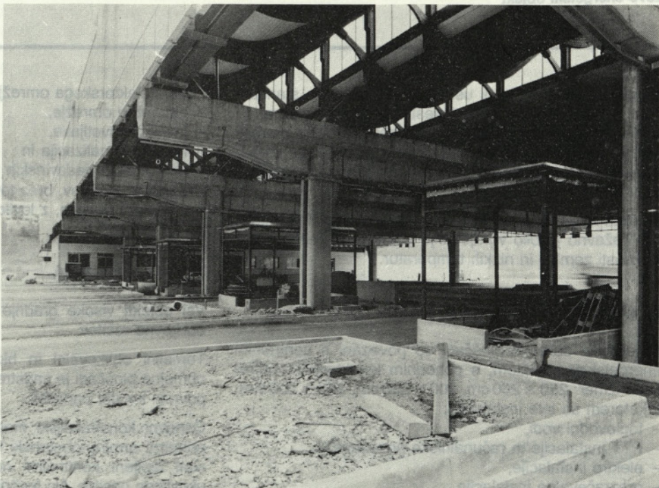
Sl. 1. Jugoslovanska nadstrešnica, potniški del med gradnjo
