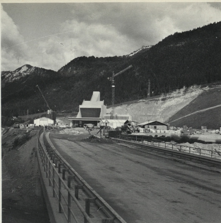
Predor Karavanke južni portal
