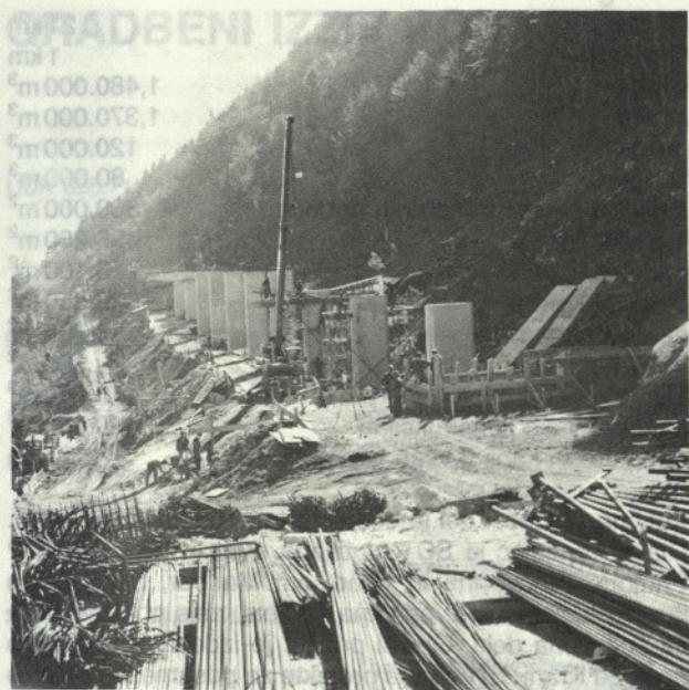
Sl. 1. Viadukt PODMEŽAKLA
