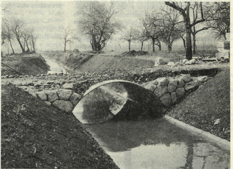
Sl. 4. Izgradnja melioracijskih jarkov
