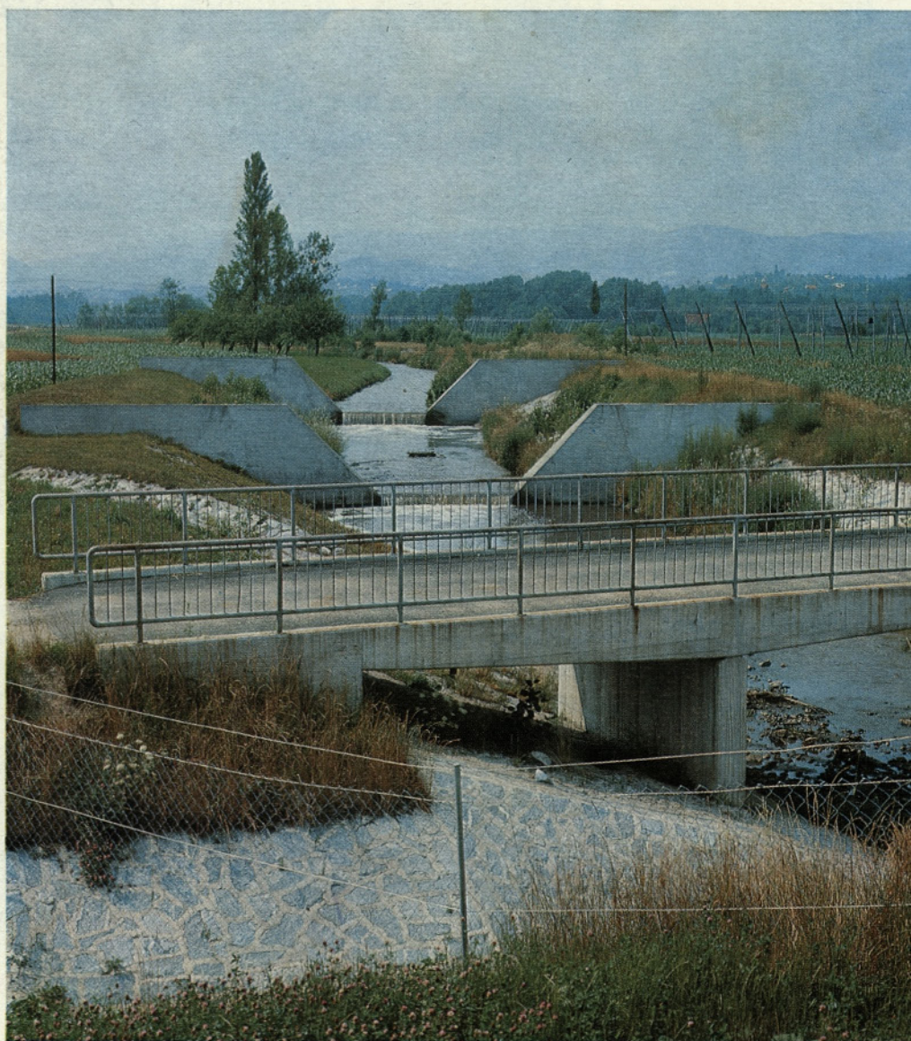
VODNOGOSPODARSKO PODJETJE MARIBOR: Regulacija Dravinje ob hitri cesti Hoče—Levec. Izvedba z membranskimi pragovi.
