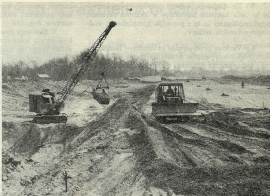
Sl. 6. Izkop gramoznega materiala v trasi potoka Grajene in formiranje nasipa — levi breg dovodnega kanala SD 2
