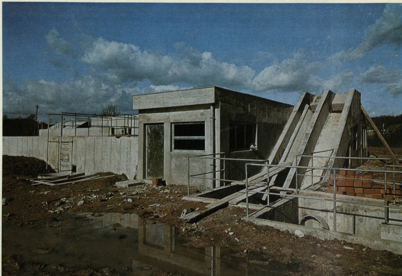
Gradnja čistilne naprave v Cerknici I. faza (3000 E), tik pred zaključkom
