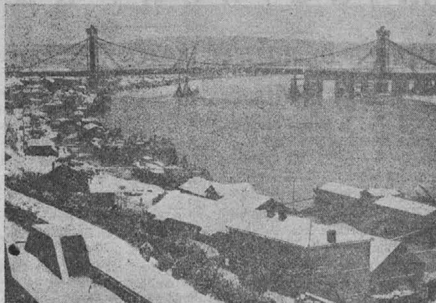
Pogled na novi most, ki veže Beograd z Zemunom. Novi savski most spada med najboljše dela moderne tehnike. Z gradnjo se je bilo pričelo leta 1930 in je letos končalo. Beograd in Zemun bosta preko mosta zvezana z železniško cesto, tako, da bosta lahko obe mesti enotno trgovali. Na obeh straneh mosta bodo postavljeni umetni kipi, po načrtu prof. Mestroviča.
