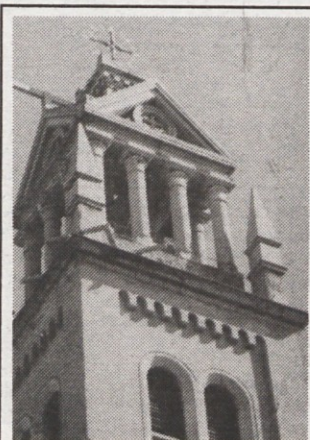
KONČNO - Obnova zvonikov župnijske cerkve v Ribnici.
