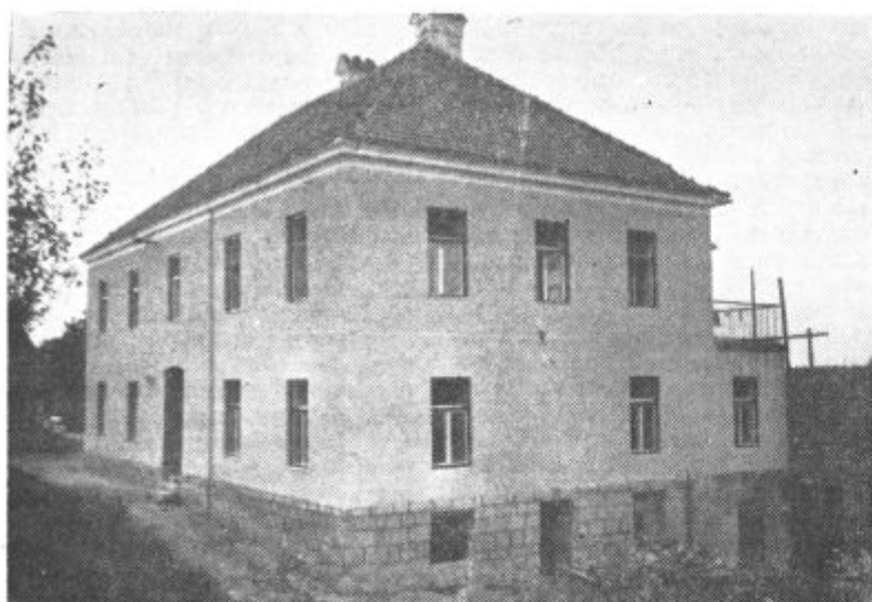
V Zgornji Ščavnici se je prizadevalni učiteljski kolektiv med letošnjimi šolskimi počitnicami lotil obnove obeh šolskih zgradb. V tej akciji se je zelo angažiral tudi šolski odbor, zlasti pa je veliko pomagal šolski upravitelj Rudi Roter. Na sliki: obnovljena stara šolska zgradba
