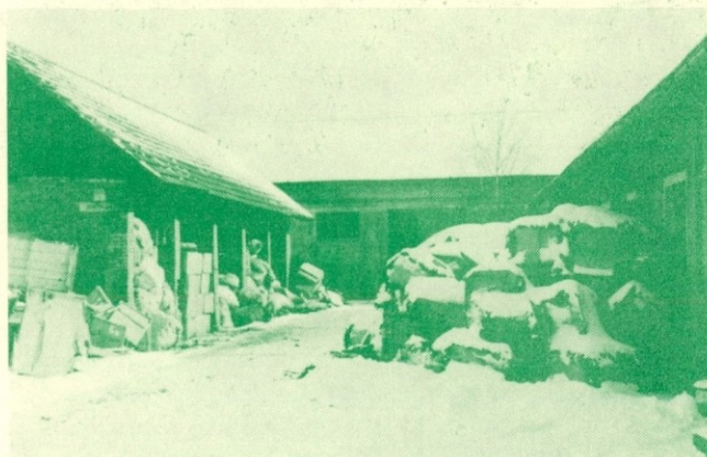
Skladiščni prostori tekstilnega obrata v Bohovi so že od nekdaj premajhni
