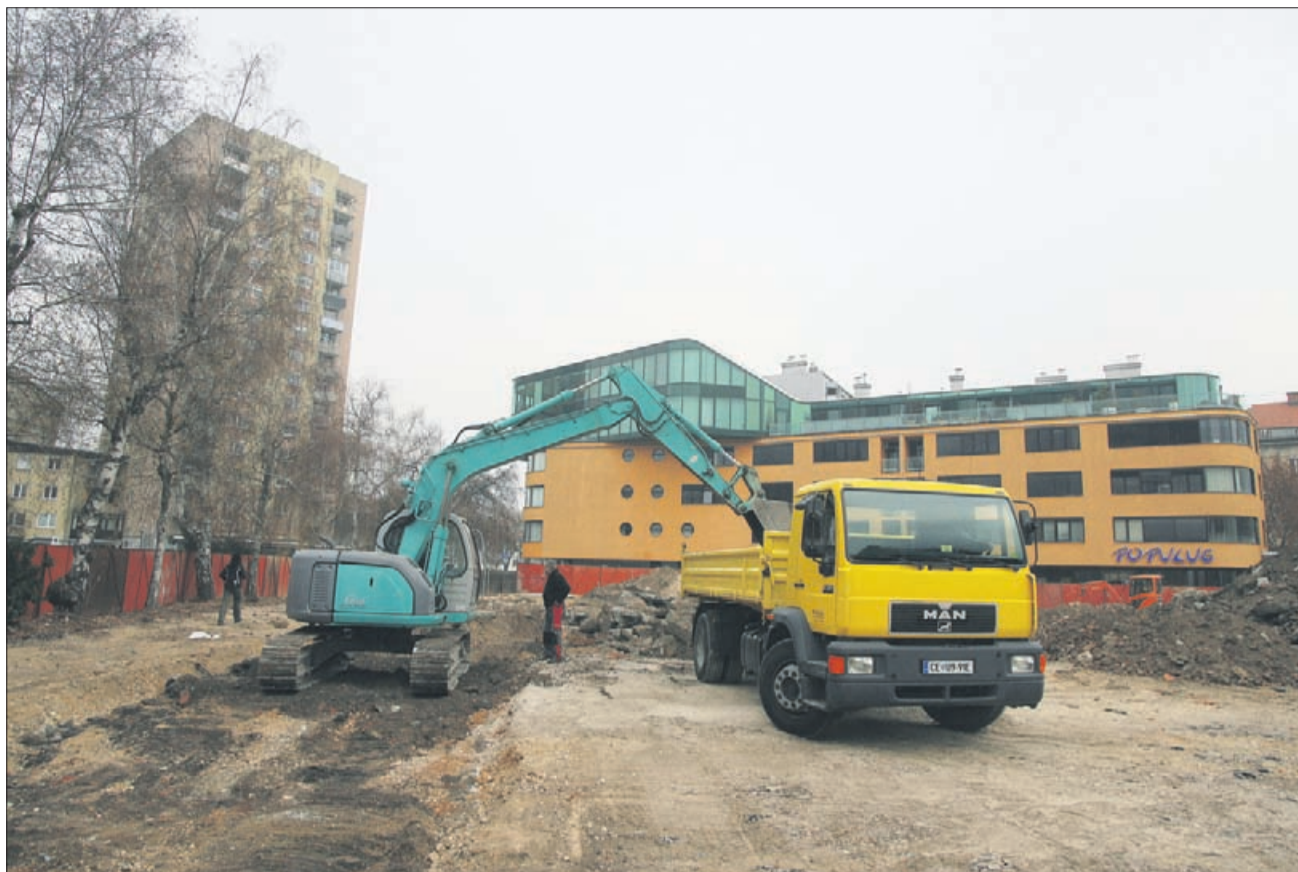
Zgrajeno parkirišče za poslovnim objektom Maksimilijan ob Jurčičevi ulici in gradbeni stroji na njem so le uvod v predhodna arheološka izkopavanja na tem območju.
