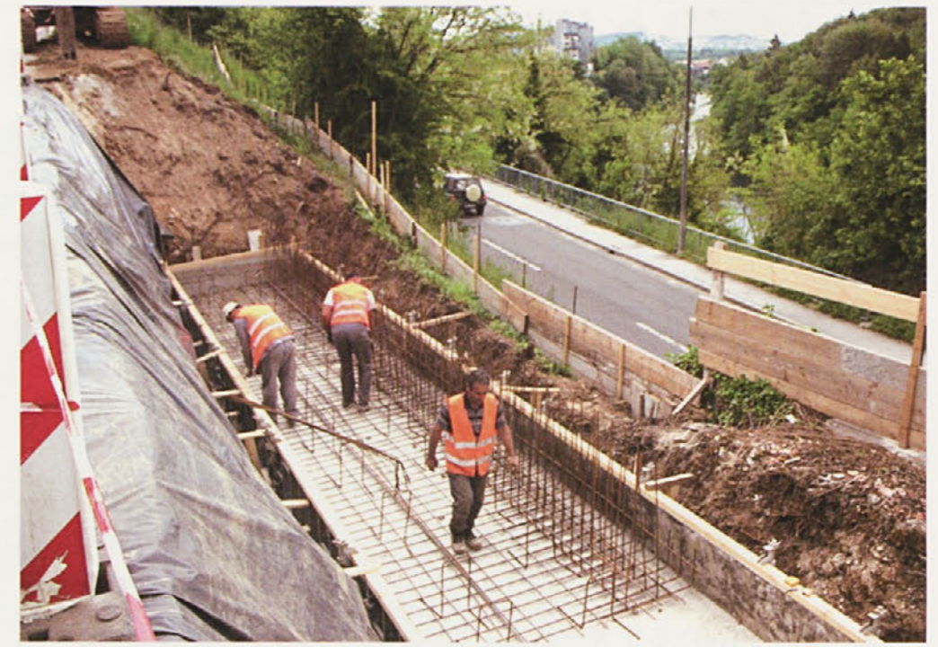
Temelj opornega zidu nad Seidlovo cesto, ki bo moral zdržati težo Koštialove ulice in prometa po njej, so mojstri temeljito utrdili. (Foto: M. Moškon)
