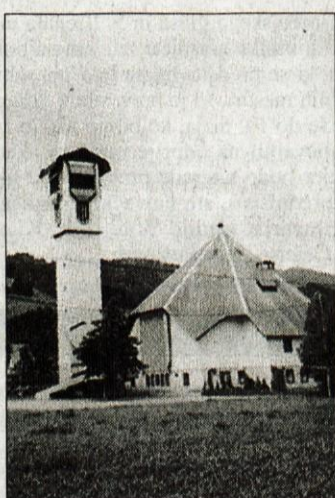
Nova cerkev sv. Martina v Ušeničnikovih Poljanah, zgrajena 1970
