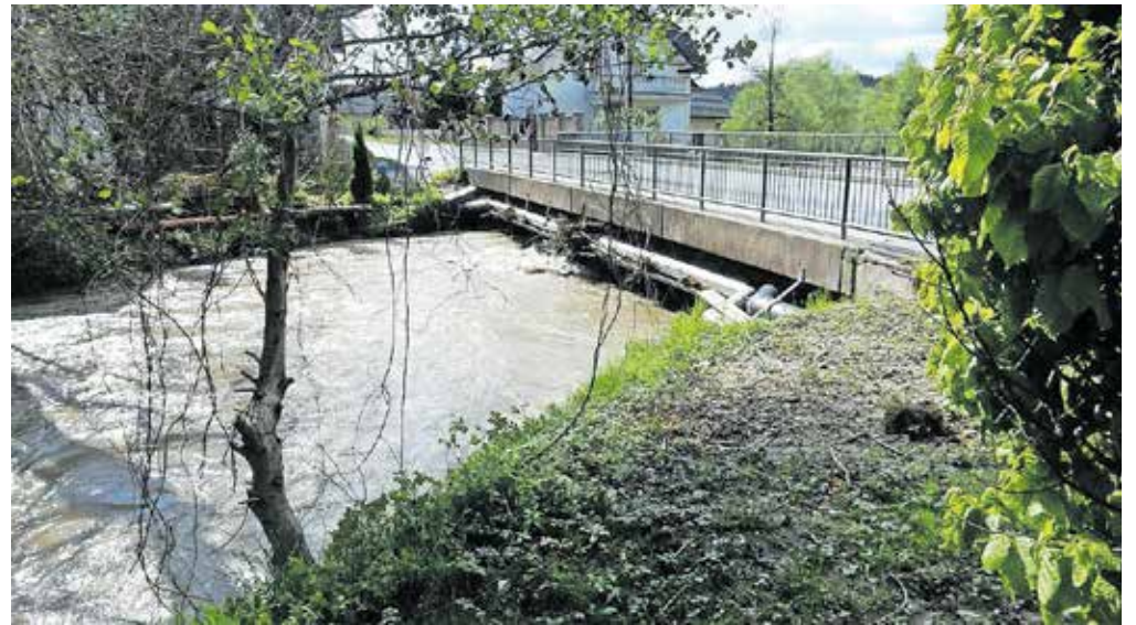
Most v Vrhpolju: zaradi poplav ogrožena cev za pitno vodo / FOTO: ARHIV PROJEKTA MUHA
