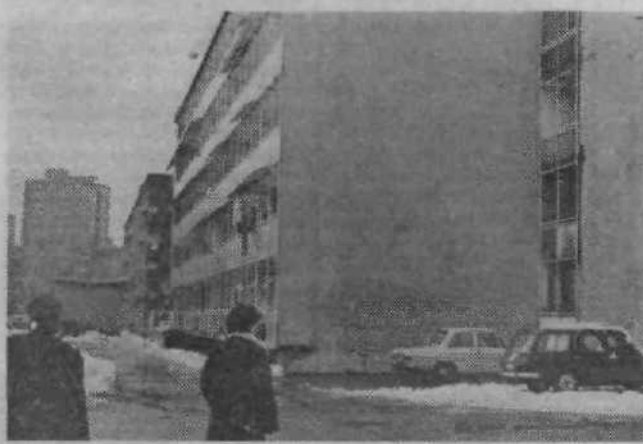
Nadzidave blokov so predvidene v Črtomirovi ulici 22, 23 do 25, 24 ter 27 do 29 in 31; v Neubergerjevi 16, 18 do 20 ter 22 do 24 in v Topniški 60 do 64.
