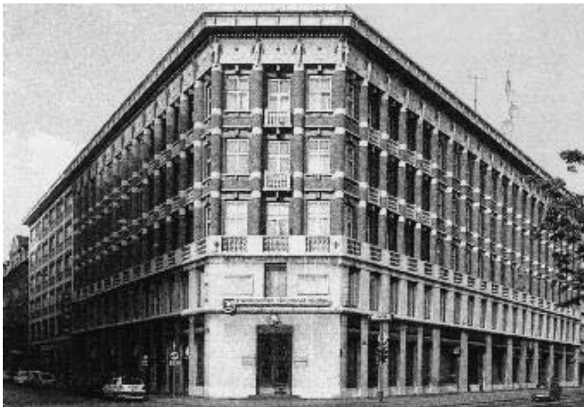
2. Verwaltungsgebäude der Versicherungsgesellschaft Vzajemna , Ljubljana, 1928-30, Ecke Miklošičeva ulica / Trg Osobodilne fronte
