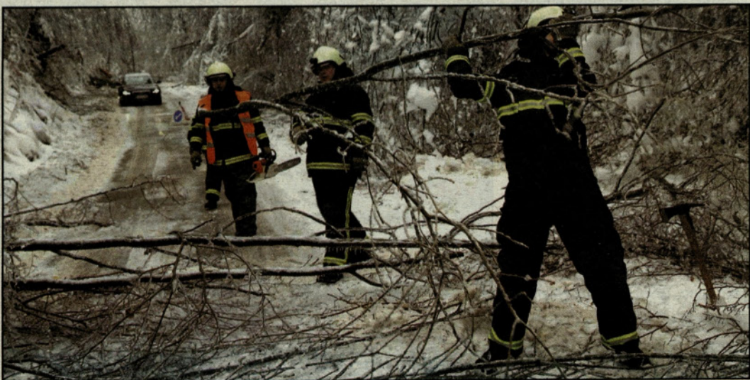
Odstranjevanje padlih dreves na cesti Založe-Podsevčnik
