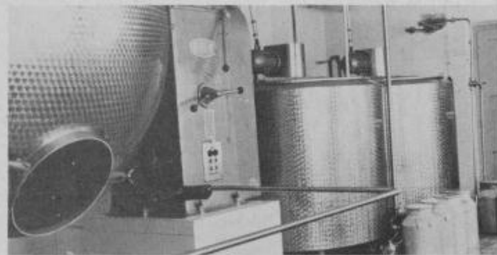
Del obnovljenega obrata ptujske mlekarne
