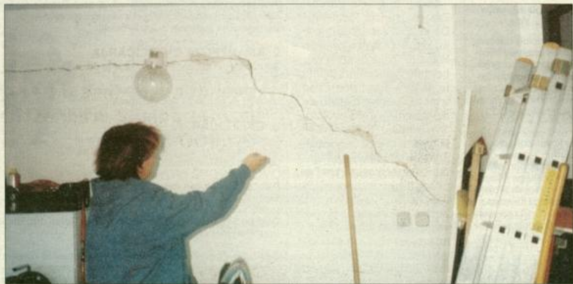
Rudarska inšpekcija je za včeraj napovedala ogled poškodb na hiši Šmalčevih. Mira Šmalc ob eni izmed razpok v le pet let staro garažo. Razpokana je dobesedno vsa, sicer 18 let stara hiša, pa tudi povsem nov, le dve leti star prizidek. Ob miniranju v kamnomolu se razpoke širijo, nastajajo nove. Ploščice padajo s sten tako pogosto, da jih sproti lepijo nazaj kar z marmelado.
