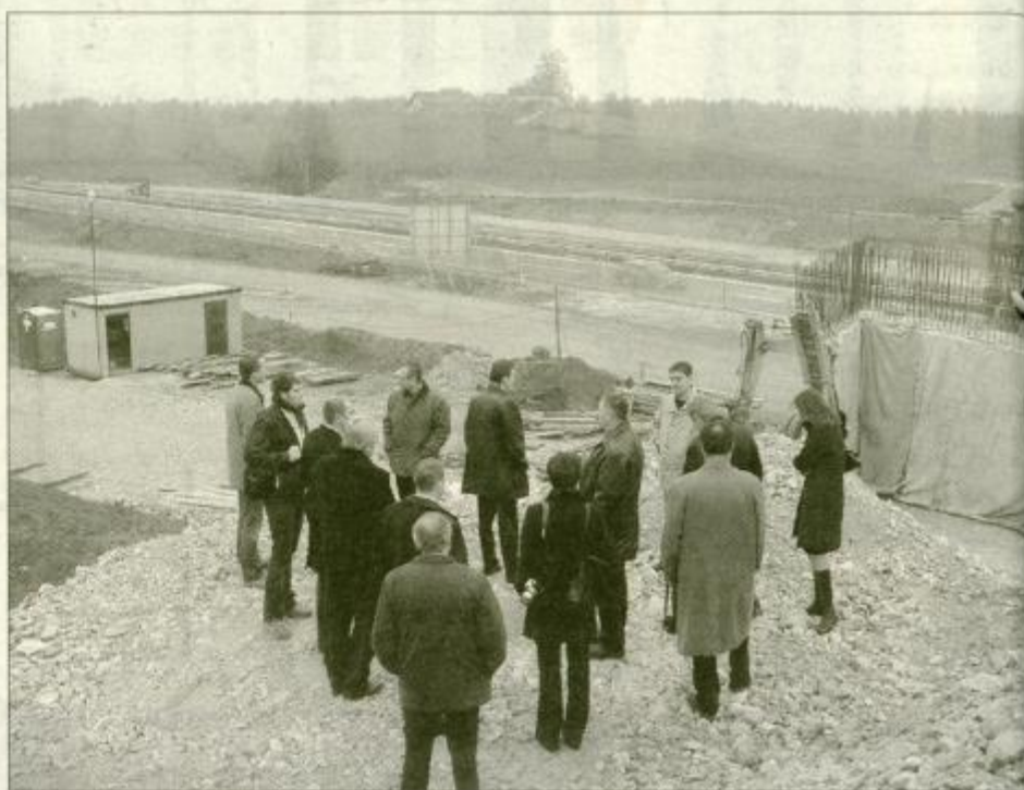
Na Lopati je že vse nared za gradnjo nadvoza in priključkov na avtocesto.
