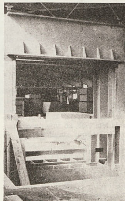
TVP — gradnja nove stiskalnice in sušilnice
